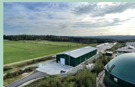
KUMAC-Anlage an der Biogasanlage Rotschau - Luftbild nach Fertigstellung
