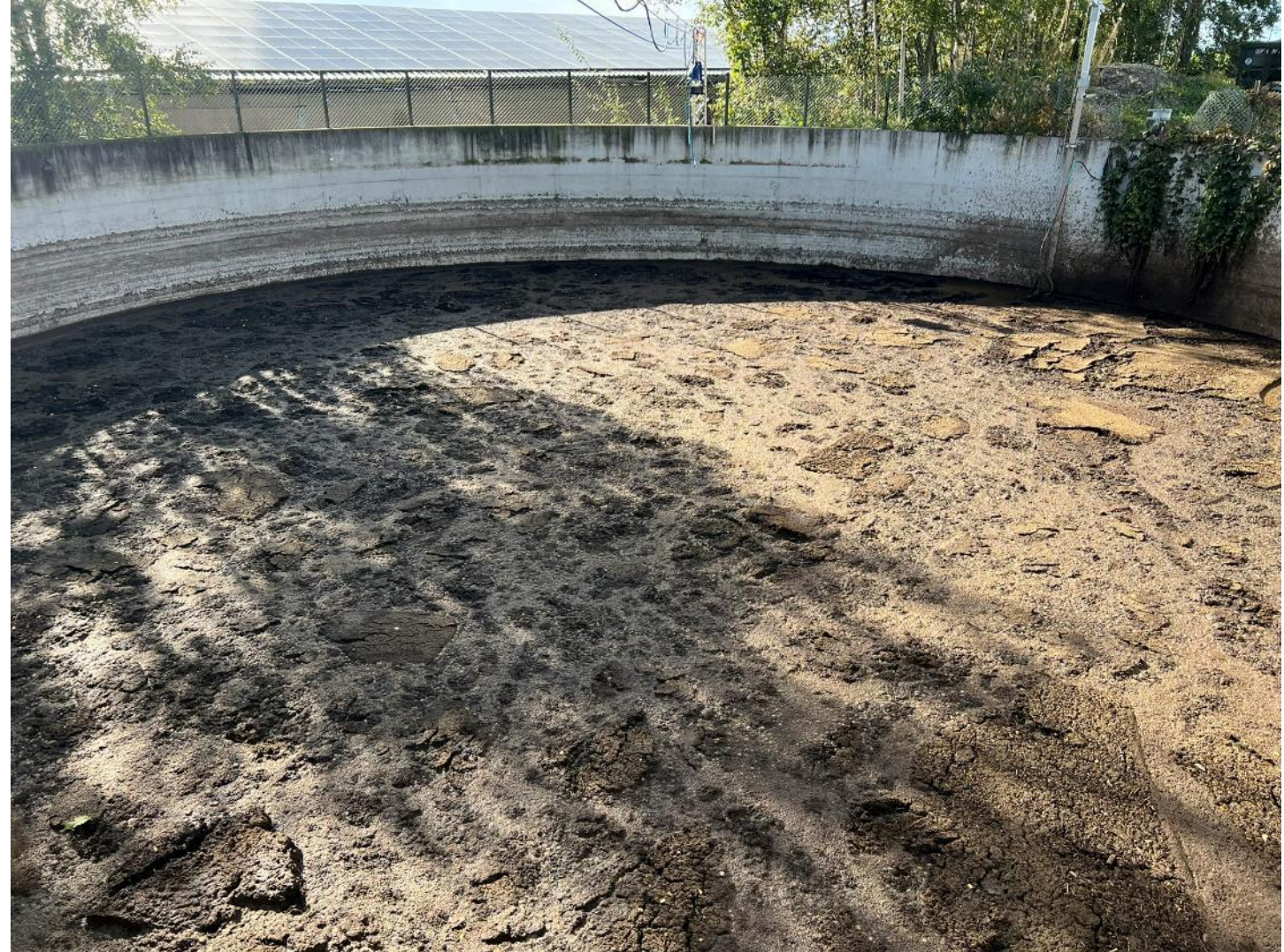
Neubildung der Schwimmschicht eine Stunde nach dem Rühren
