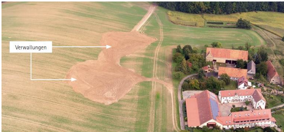
Verwallungen auf der Ackerfläche nach der Fertigstellung
