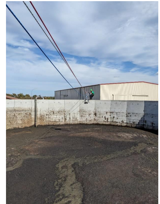
Absturzsicherung beim Bewegen der Haube
