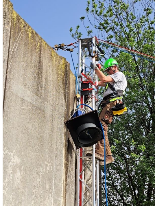
Absturzsicherung beim Aufbau
