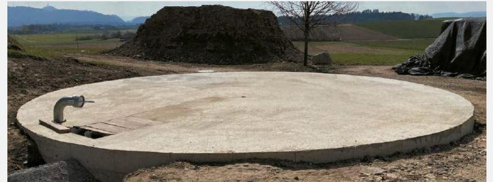
Foto: Abdeckung von Güllelagern zur Reduktion von Emissionen, KOLAS/KVU, Juni 2022
