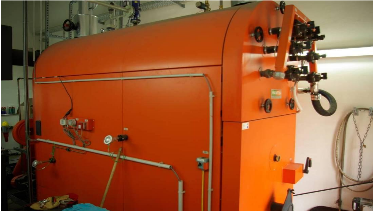
Biomassekessel MAWERA, Lehr- und Versuchsgut Köllitsch
