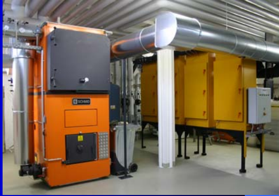
wassergekühlte Vorschubrostfeuerung mit Rauchgasrezirkulation
