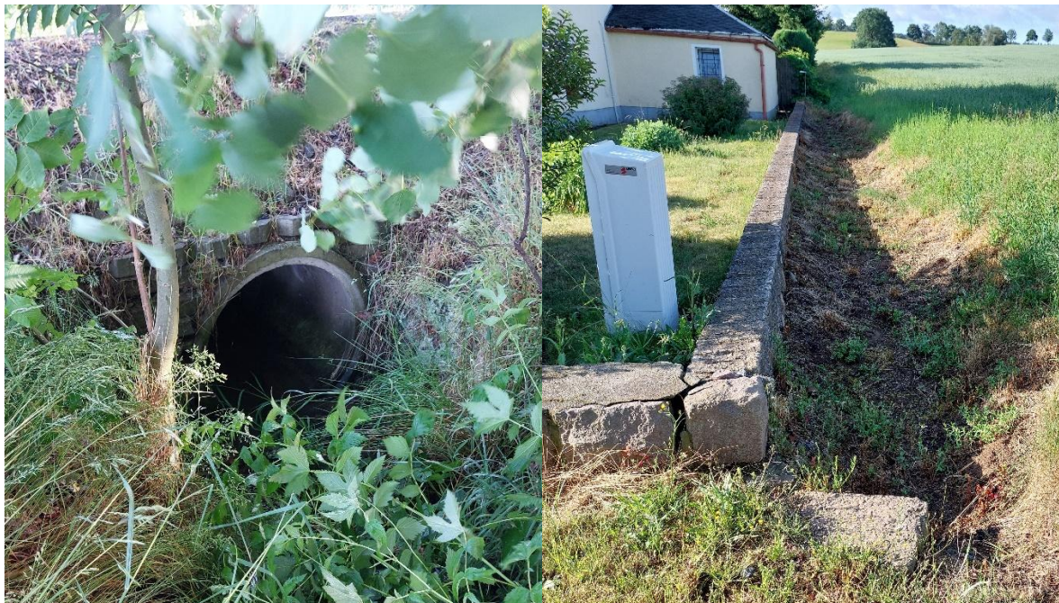
Abbildung 2: Erfassung von Durchlässen und Mauern im Gelände
