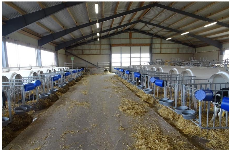
Abbildung 11: Neu errichteter Kälberstall mit reichlich Frischluft, sowie Mikroklima durch Kälberiglus
