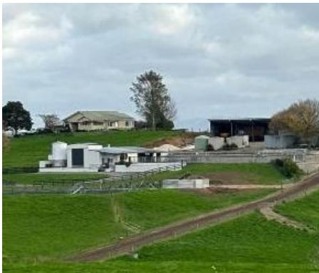
Abbildung 1: Shed – Überdachter Melkstand mit außenliegendem Vorwartehof
