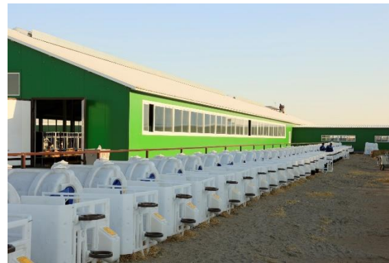
Abbildung 6: Kälberaufzucht in Südkasachstan mit Außenklima
