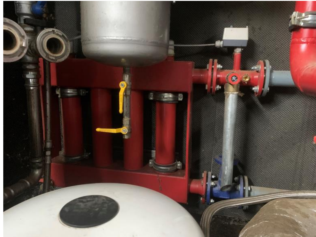
4 Heizschwerter à 20 kw (Stabilisierung Notstrombetrieb)
