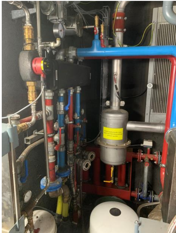
4 Heizschwerter à 20 kw (Stabilisierung Notstrombetrieb)
