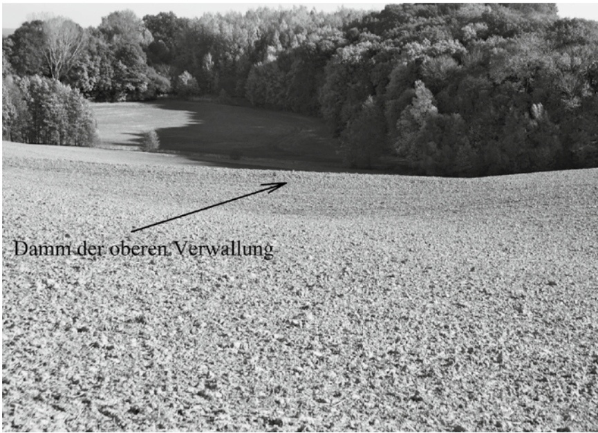
Bild 3: Integration der oberen Verwallung in die Winterweizenbestellung 2014 mit Blick auf den wasserseitigen Dammbereich (Quelle: LfULG)
